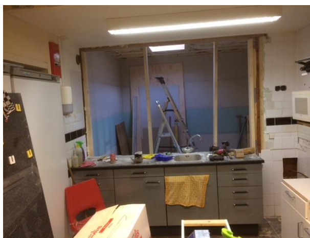
Een indruk hoe de keuken verplaatst wordt. Daardoor wordt de kantine uitgebreid met meerde zitplaatsen.
