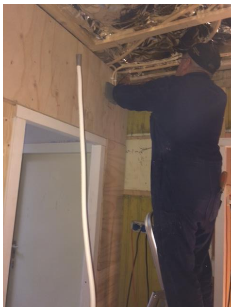
Ook wordt electra nieuw aangelegd door Bert
